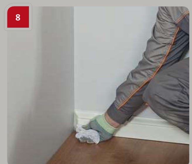
8 Veeg de eindvlakken van aanliggende producten af met een natte doek om stof en andere verontreinigingen te verwijderen.
