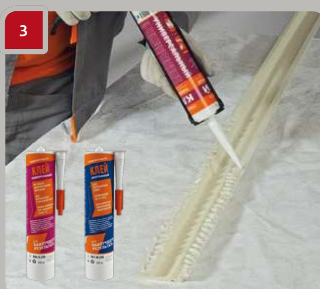
3 Breng G06M290 aan op het montageoppervlak (alleen op de kruising op de muur) of G10U290 langs de lengte van het product. De dikte van de aangebrachte lijmlaag moet 3-5 mm zijn.
