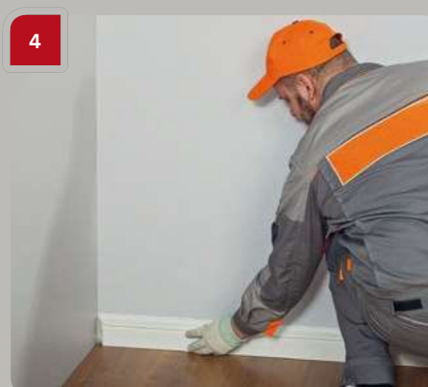
4 Bevestig het product op de plek waar het moet worden geïnstalleerd overeenkomstig de markeringen op de muur. Duw het product langs de hele lengte aan zodat de lijm uit het hele voegoppervlak wordt geperst.
