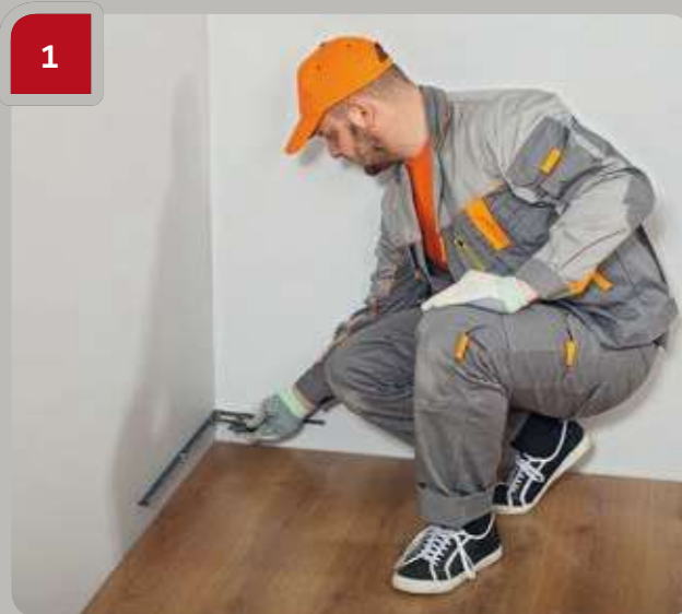
1 Gebruik een hoekmeter om de hoek van de kamer te meten.
