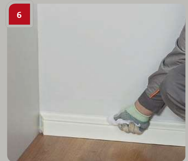
6 Veeg indien nodig het gebied rond de voeg tussen het product en de muur schoon met een vochtige doek als u de G06M290 gebruikt; gebruik aceton als u de G10U290 gebruikt.
