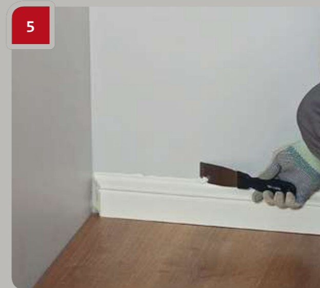
5 Verwijder onmiddellijk na het lijmen de overtollige lijm met een plamuurmes.
