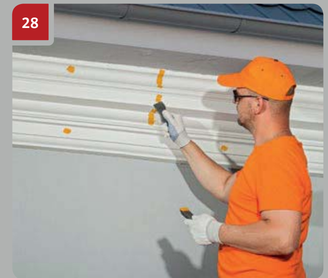
Breng stopverf op de behandelde plekken en op de schroefkoppen aan. Gebruik stopverf voor auto's.
