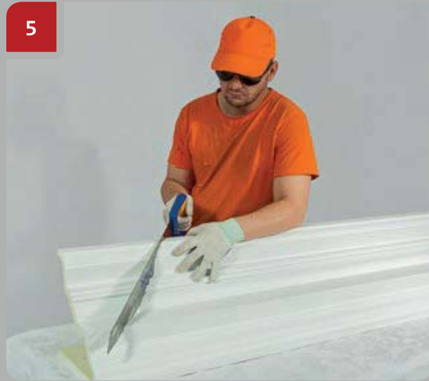
5 Voltooi de bewerking met een handzaag.
