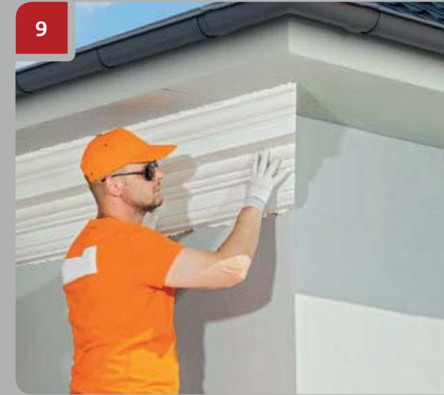
9 Plaats het artikel op de plek waar het moet worden geïnstalleerd overeenkomstig de markeringen op de muur. Druk het artikel over de gehele lengte hard genoeg aan totdat de lijm uit de voeg komt.
