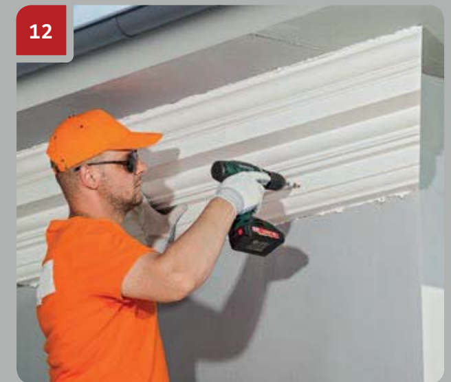
12 Gebruik een schroefpistool om de inslagankers 2 mm diep in het artikel te duwen.
