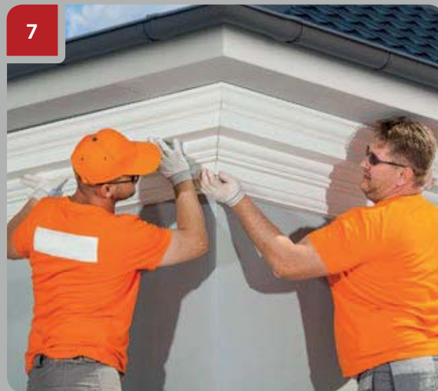
7 Controleer of het patroon en profiel van het artikel met elkaar overeenkomen.
