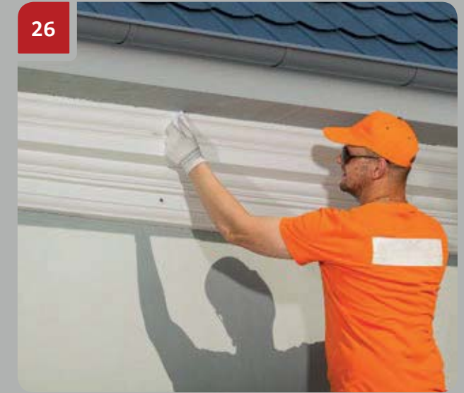
Gebruik aceton en een doek om overtollige lijm te verwijderen.
