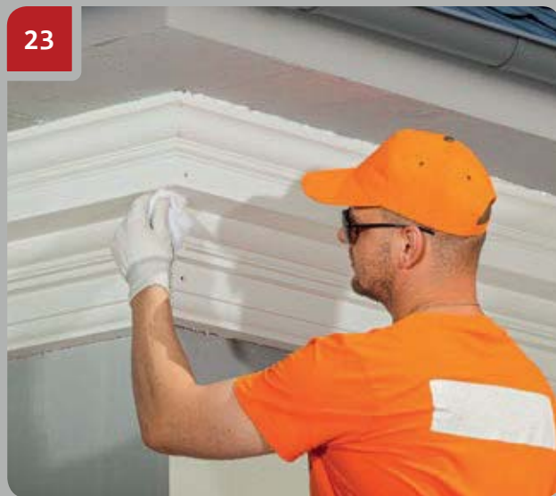
Wrijf de voeg schoon met een in aceton gedrenkte doek.
