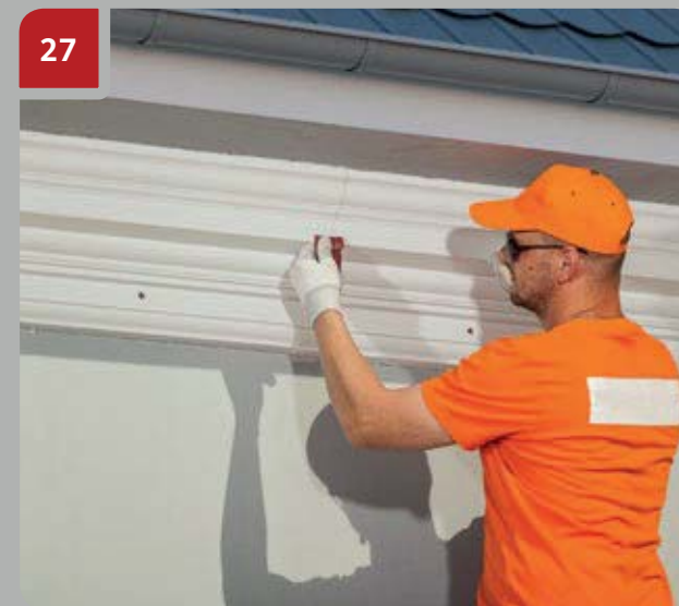
Wacht 3 uur en gebruik zacht schuurpapier om de voegen te schuren.
