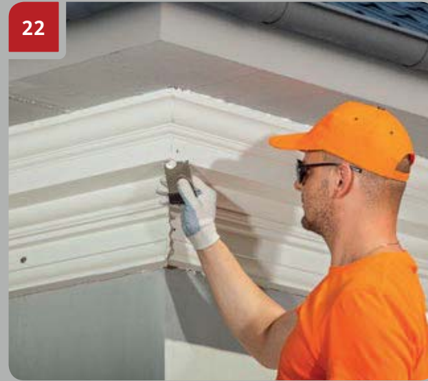
Onmiddellijk na het lijmen verwijdert u de overtollige lijm met een paletmes.
