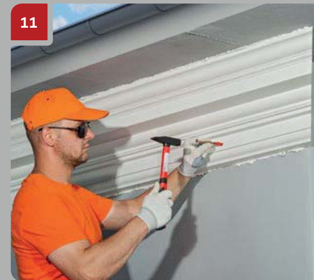
11 Bevestig het artikel met slagankers.
