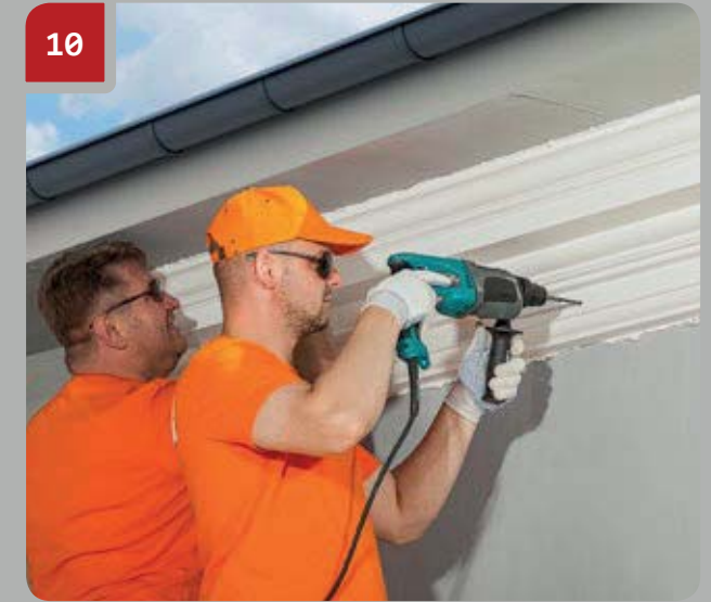
10 Gebruik een perforator om gaten te maken voor slagankers met een tussenafstand van ongeveer 600 mm.
