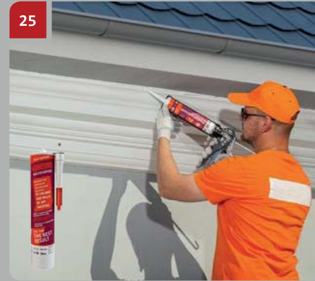
Op plekken waar het artikel tegen een oppervlak aanligt en waar er geen lijm uit de voeg is gekomen, vult u de openingen met meer lijm.
